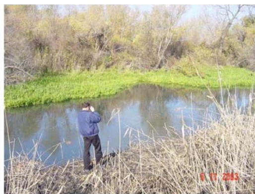
Slika 3-6: Suženje Kanala zbog rastinja u plitkim delovima Kanala
