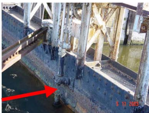
Slika 3-18: Polomljena osovina na gornjim vratima
