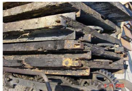
Slika 3-13: Oštećenja drvenih ploča
