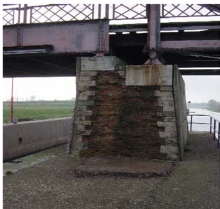
Slika 3-37: Beton koji je pao sa mosta pokrivaču
