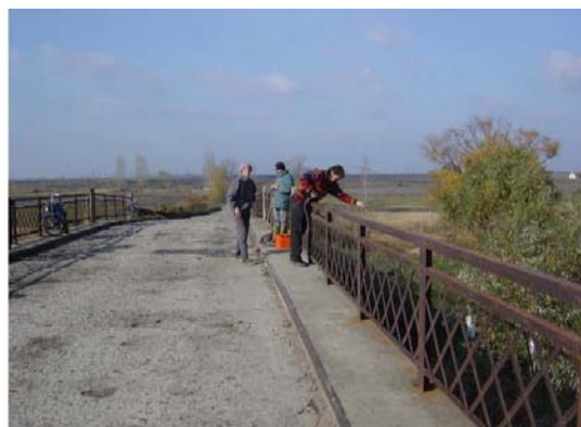
Slika 3-43: Begejci-Most Novi Itebej
