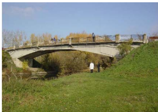
Slika 3-42: Begejci-Most Novi Itebej
