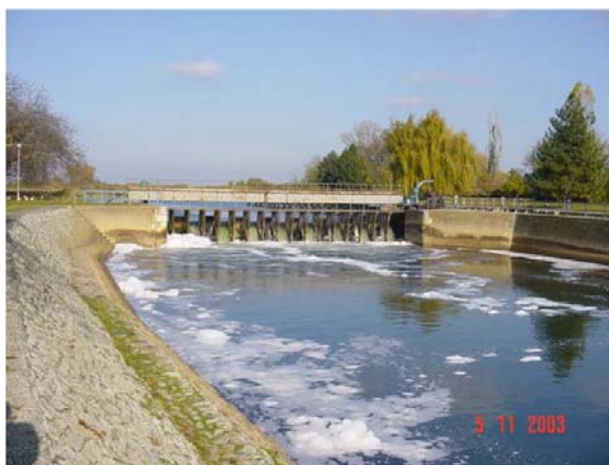
Slika 3-9: Ustava gledana sa nizvodne strane
