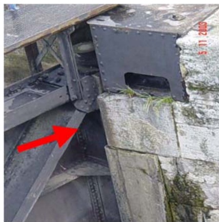
Slika 3-36: Ispad/ iskakanje iz žleba
