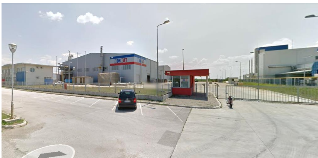
Slika 5. Ulaz u kompleks
