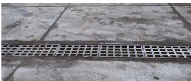
Slika 9. Prihvatni drenažni sistem
