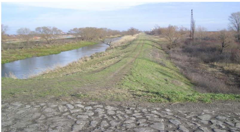
Слика 21. Изглед круне насипа дуж Канала Бегеј
