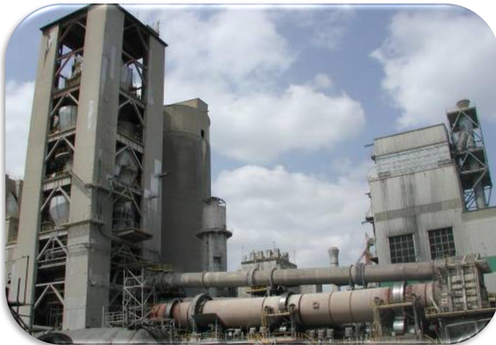
Slika 2.4 Rotaciona peć sa četvorostepenim ciklonskim predgrejačem
