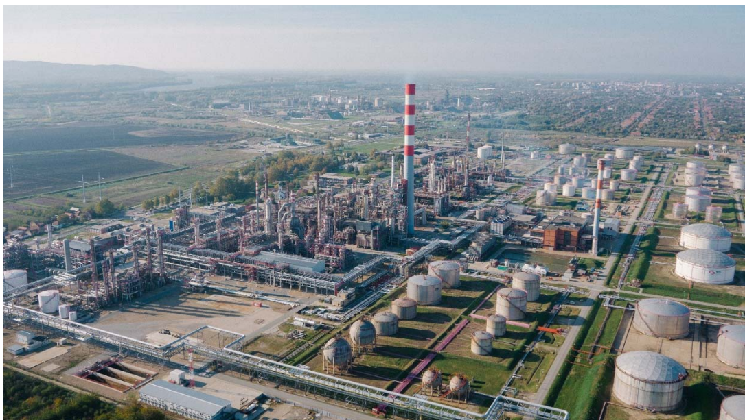
Slika 2.7. Južna industrijska zona Pančevo
