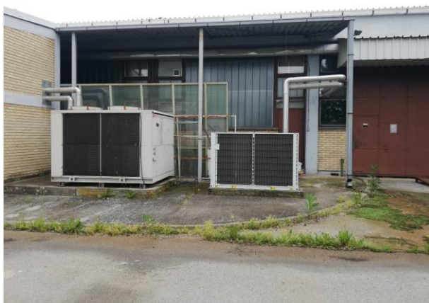
Slika 10. Objekti za mašinske instalacije grejanja i klimatizacije
