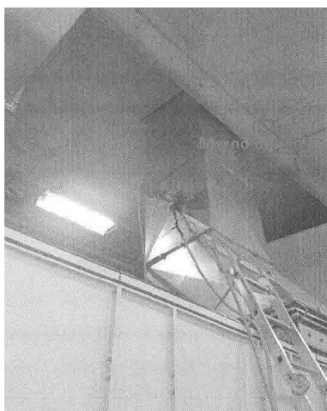
Slika 13. Merno mesto i emiter ventilacionog sistema klima komore iz zone D
