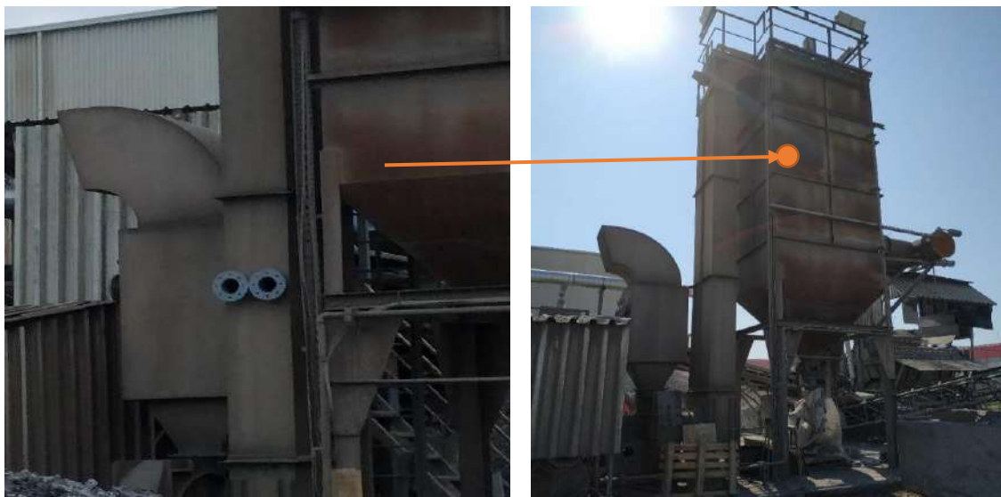
Слика 6.3.7 – Врећасти филтер за пречишћавање гасних струја из сепаратора шљаке и емитер E2
