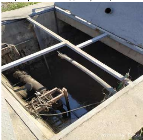
Слика 6.4.1. – Ретензион базен
