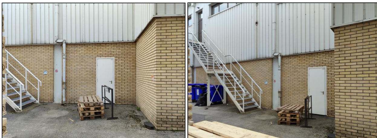
Слика 4. Део производног погона који се дограђује
