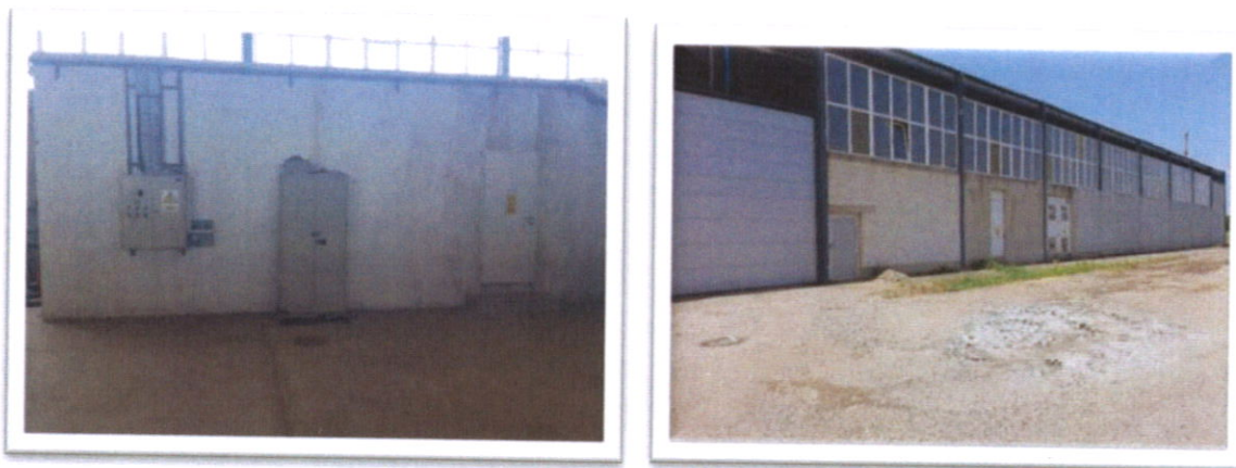
Слика 10. Трафо-станција унутар објекта на КП 5933/19
