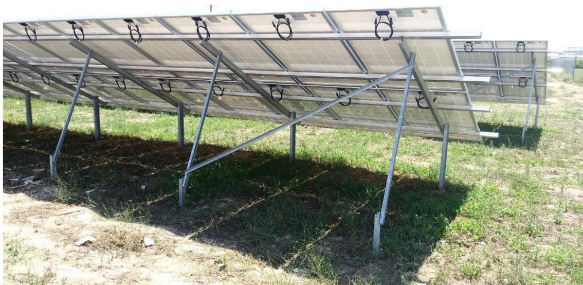
Slika 4.5.5 Način montaže noseće konstrukcije
