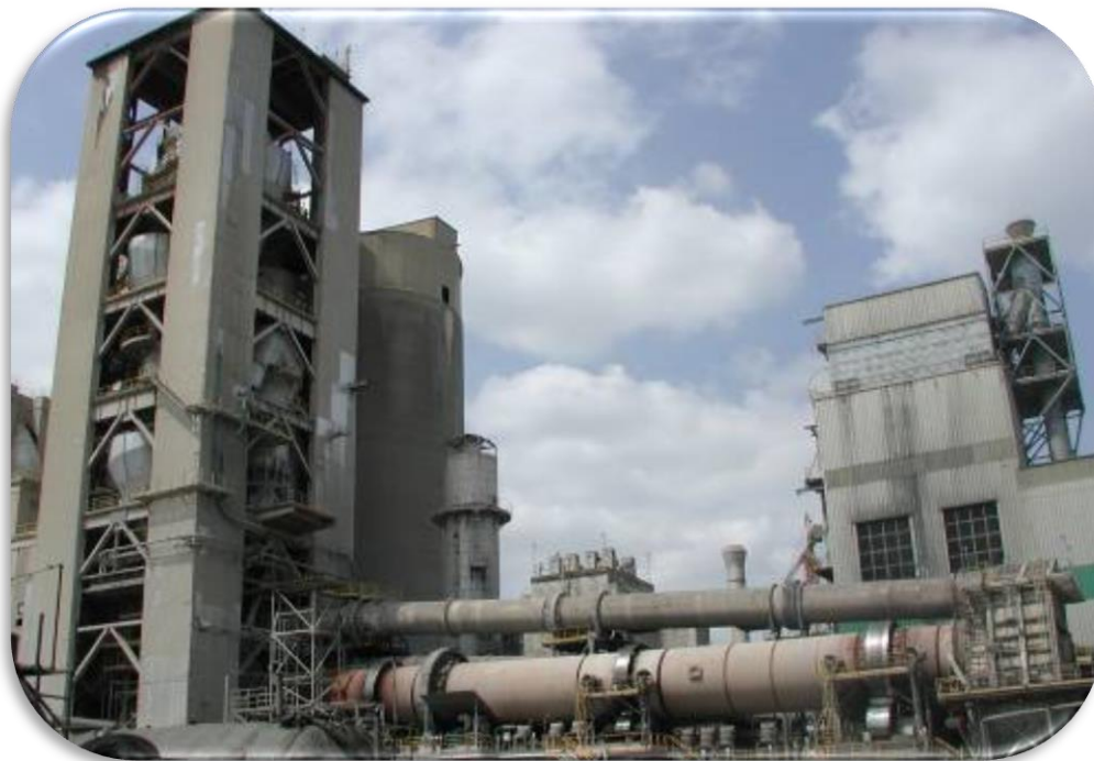
Slika 2.4 Rotaciona peć sa četvorostepenim ciklonskim predgrejačem
