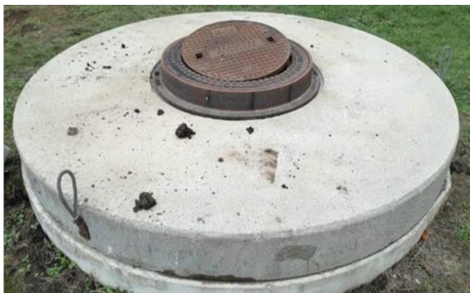
Слика 11 Сепаратор уље/вода са коалесцентним филтром
