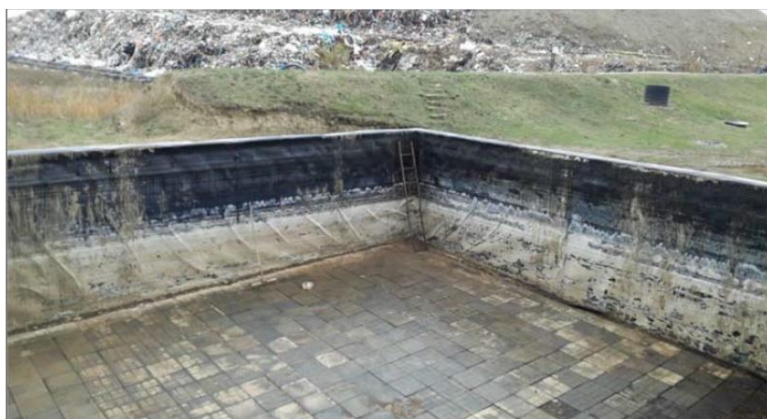
Слика 2 Бетонски базен процедних вода
