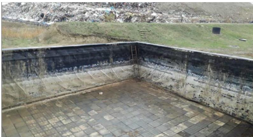
Слика 2. Бетонски базен процедних вода
