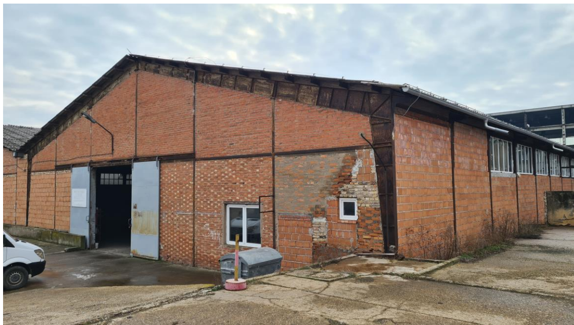
Фасада предметног објекта - улаз у халу за складиштење
